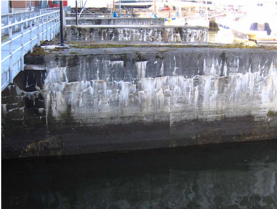
Abb. 2 Pier in Trondheim (Norwegen) mit AKR-geschädigtem Beton.
