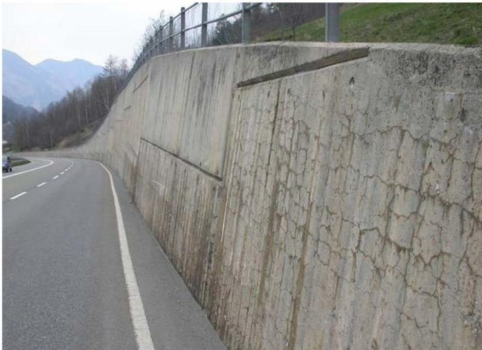
Abb. 1: Betonstützmauer mit typischen für die AKR netzartigen Rissmuster (aus [4]).
