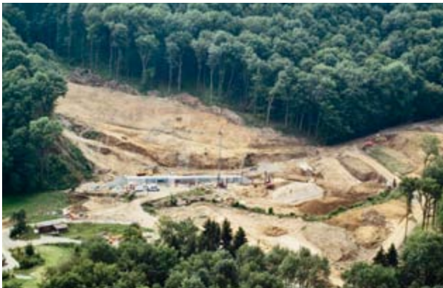
15: Luftbild der Dammaufstandsfläche. Zu erkennen ist der 50 m lange Ablaufstollen des Mülibachs.
