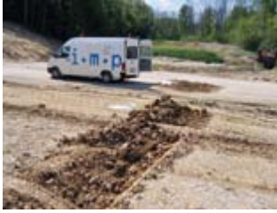
13: Probenahme für die Einbaukontrolle. Das verdichtete Material musste jeweils mit dem Bagger aufgelockert werden.
