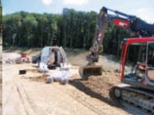
13: Prélèvement d'un échantillon en vue des contrôles de réalisation. Les matières compactées ont dû être ameublées à la pelle.
