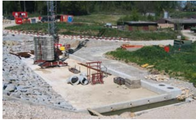
12: Der Damm-Überlaufbereich mit Tosbecken.
