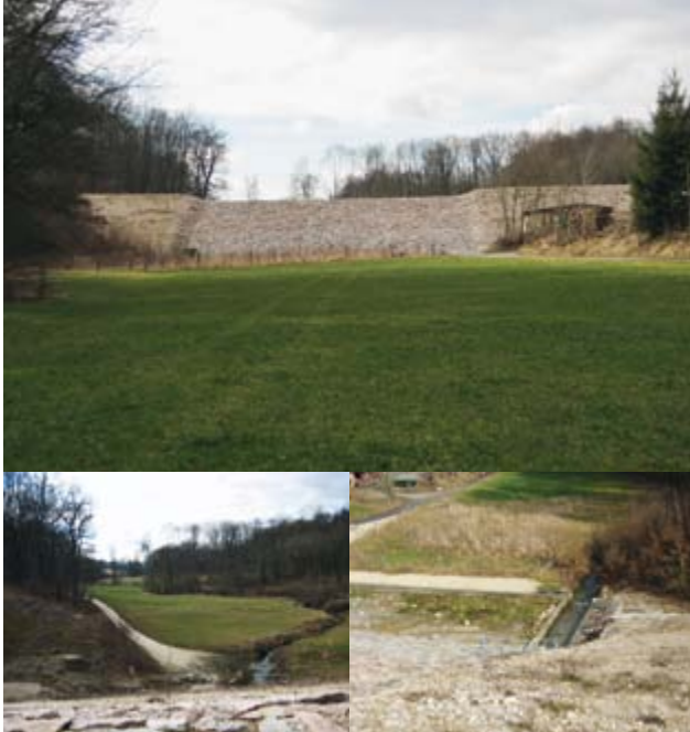
2: Der fertige Staudamm unterwasserseitig aus Distanz (oben). Gut zu erkennen ist der mittige Überlaufbereich. Unten links ein Blick in das oberwasserseitige Amphibienschutzgebiet mit Einlauf des Mülibachs. Unten rechts der Auslauf des Mülibachs, links davon das Tosbecken vor dem Überlaufbereich.
