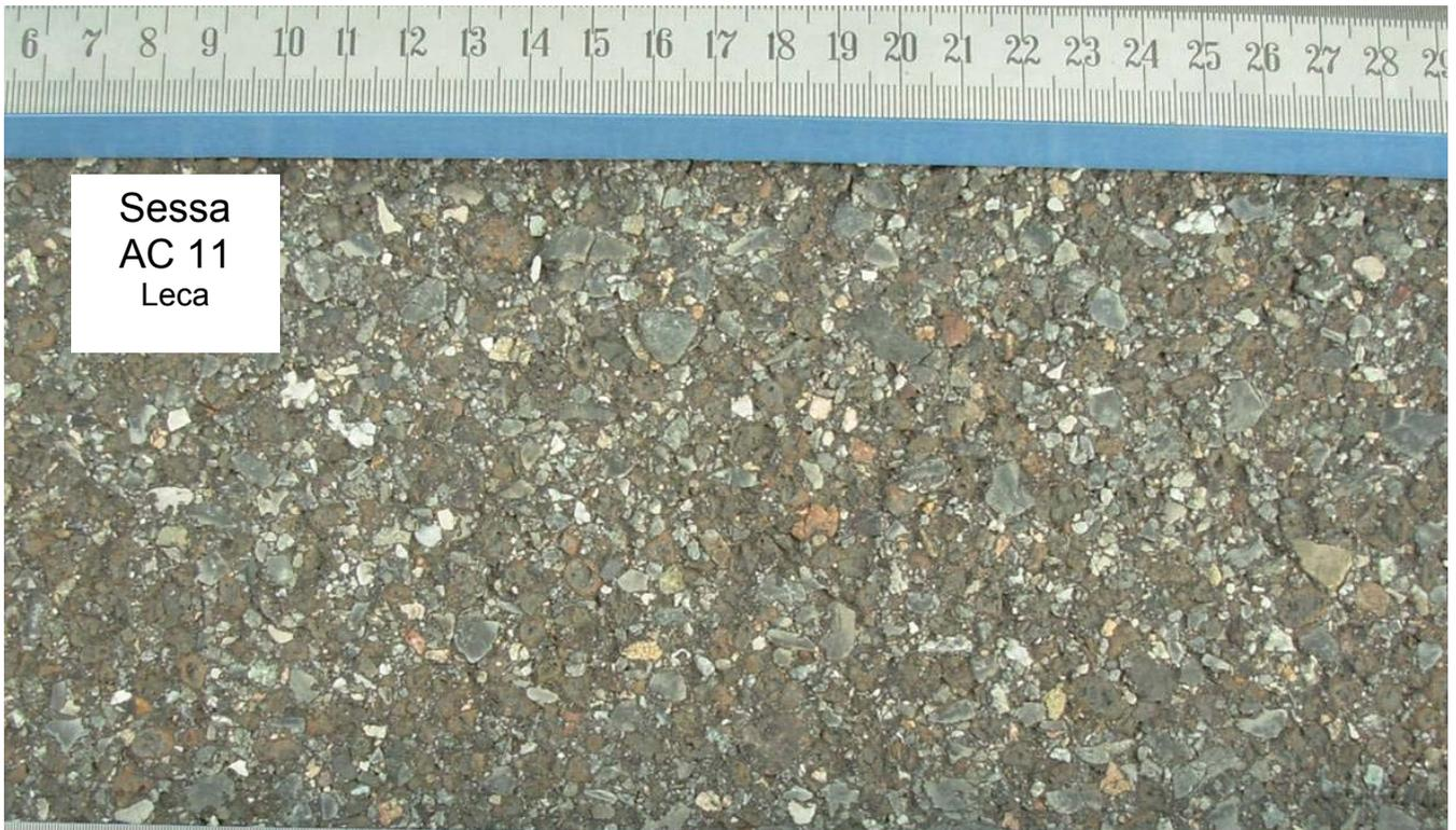
Radspur rechts; der Belag liegt in sehr gutem Zustand vor. Die Leca-Körner sind abgeschliffen.
