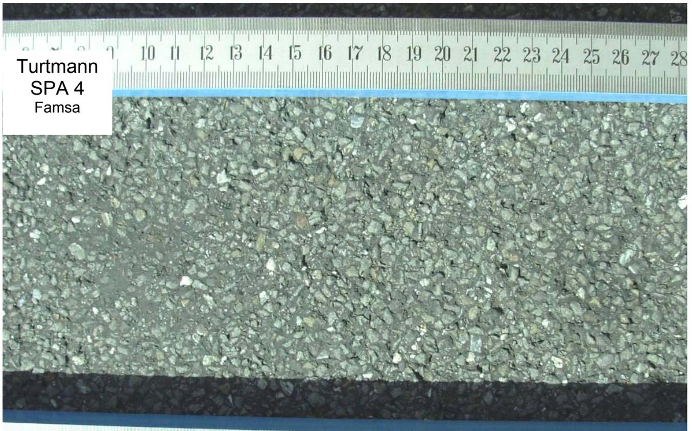
Die Fahrbahn zeigt sehr markante Spurrinnen. Radspur rechts: die Oberfläche ist sehr schmutzig und durch viel Kornausbruch gekennzeichnet.
