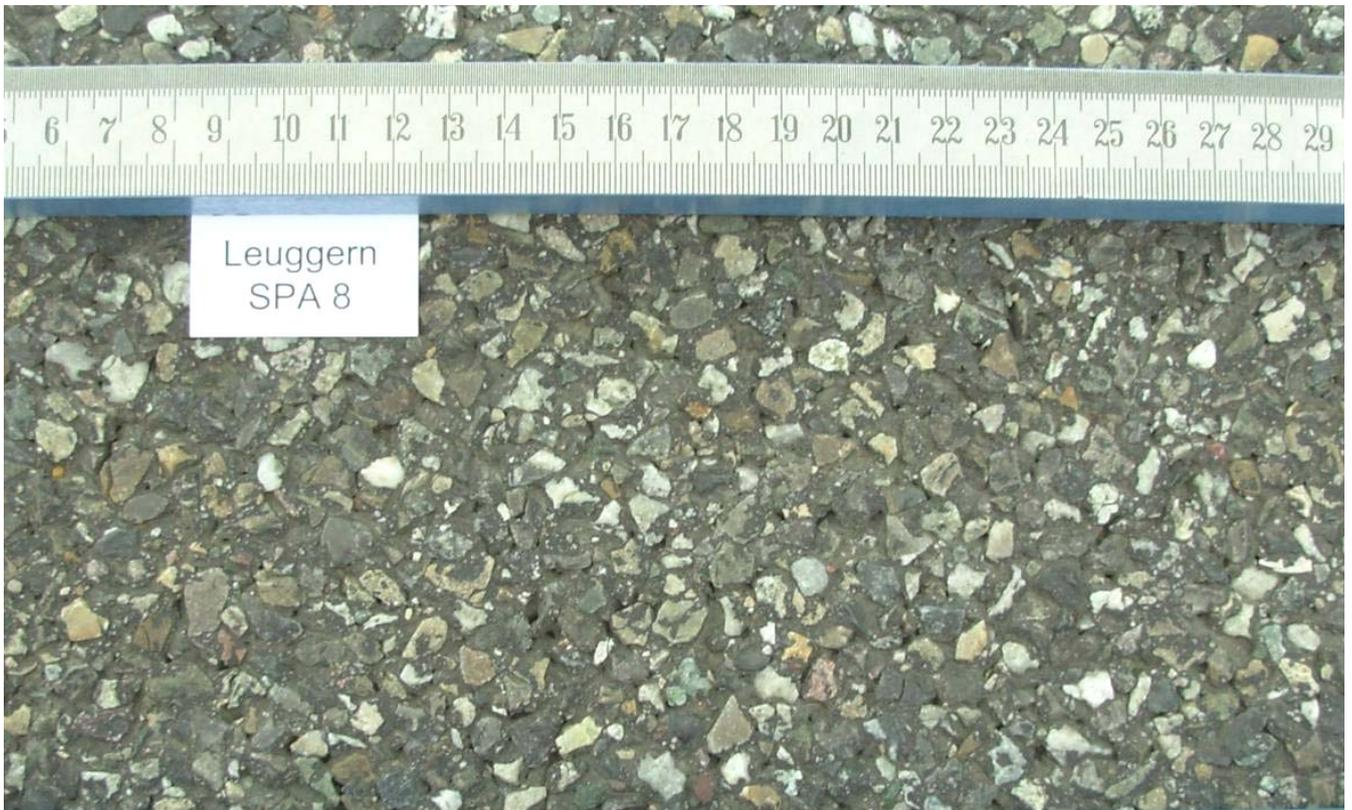
Radspur rechts; in der Radspur befinden sich einige Poren, ansonsten ist der Belag dicht. Einige Kornausbrüche in einem Abstand von 5 bis 10 cm sind zu berichten.
