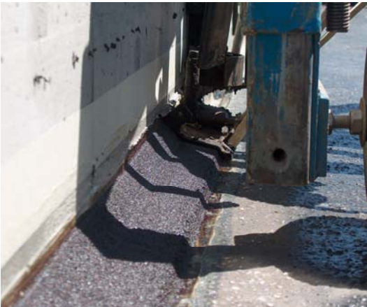
Abbildung 7: Einbringen der extrudierten Heissvergussmasse (Kittkeil / Wasserabweiser)
