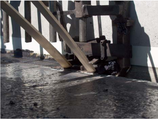
Abbildung 6: Einbringen der extrudierten Heissvergussmasse
