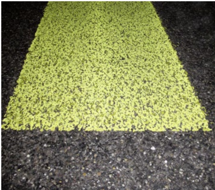
Strukturmarkierungen dienen der Sicherheit, doch können sie auch Lärmquellen sein.
