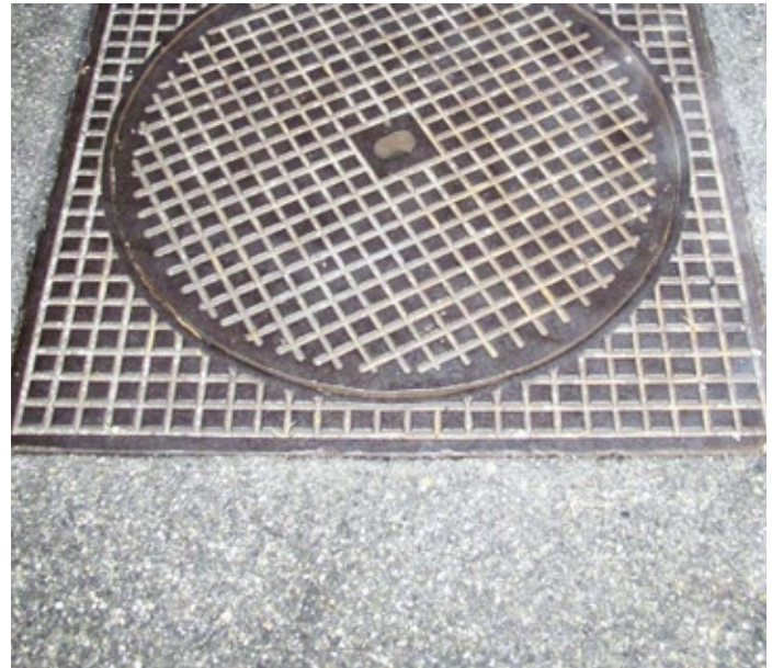
Auch Schachtabdeckungen können die Wirkung von lärmarmen Belägen beeinträchtigen.
