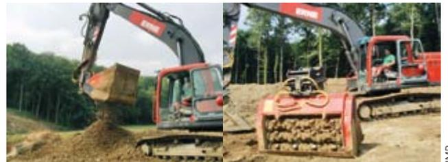
8: Links die Herstellung des für den Dammkern benötigten Materials (Alluvionen/Schotter mit Lösslehm). Rechts die dazu verwendete Sortierschaukel. Sie dient zur Regulierung des geforderten Grösstkorns.
