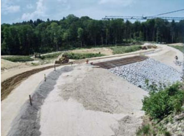
14: Die Dammschüttung im fortgeschrittenen Stadium. Die Zonierung des Stützkörpers ist deutlich erkennbar. Beim dunkelgrauen Material handelt es sich um die unterwasserseitige Filterschicht aus Kiessand.
