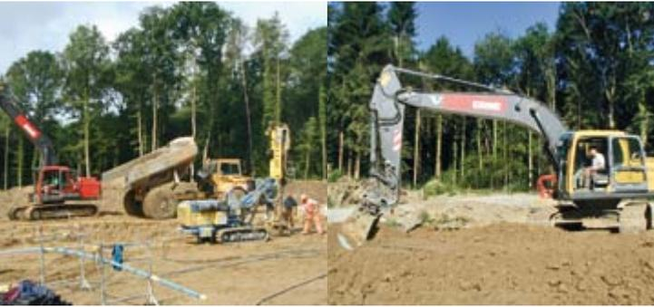
10: Links im Vordergrund: Injektionsarbeiten an der Dammaufstandsfläche. Rechts Arbeiten an einer Probeschüttung.
