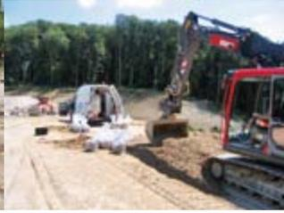
13: Prélèvement d'un échantillon en vue des contrôles de réalisation. Les matières compactées ont dû être ameublées à la pelle.
