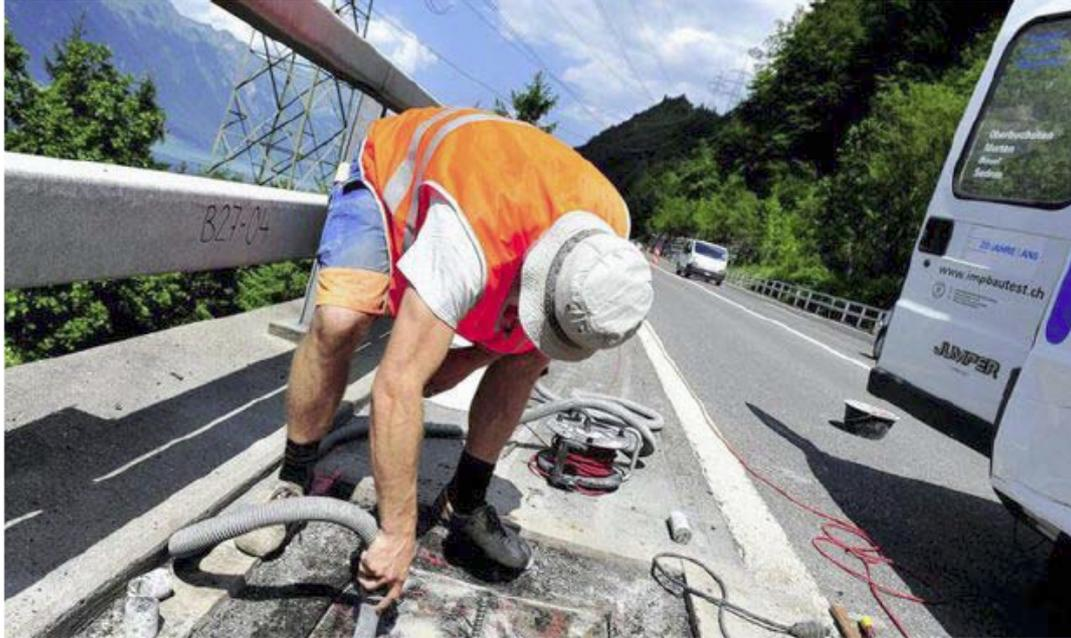
Kernbohrungen im Beton auf der A8: Stefan Jenny befreit die Bohrlöcher mit dem Staubsauger von Schmutz. Links unten und unter der Bildmitte rechts sind Betonproben zu sehen, die der Baustofflaborant später genauestens untersuchen wird.
