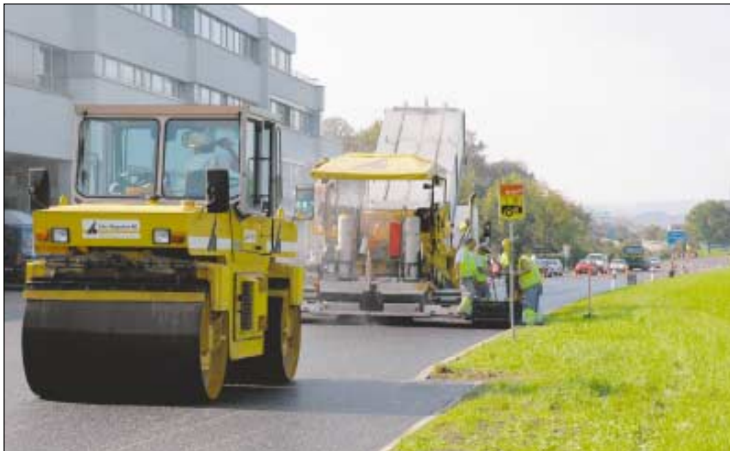
Schweisstreibende Arbeit: Das Einbringen des lärmarmen Strassenbelags.
